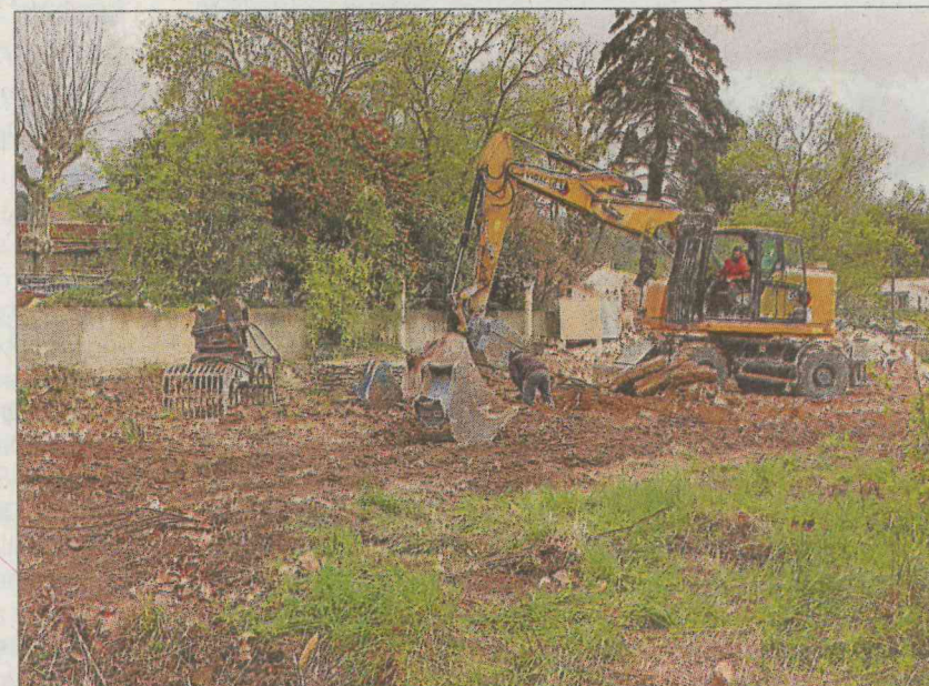
Les travaux de démolition ont commencé le 27 mars.
